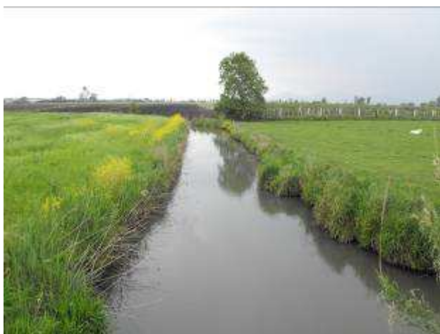
Tipico esempio di gestione della vegetazione di un canale di bonifica
