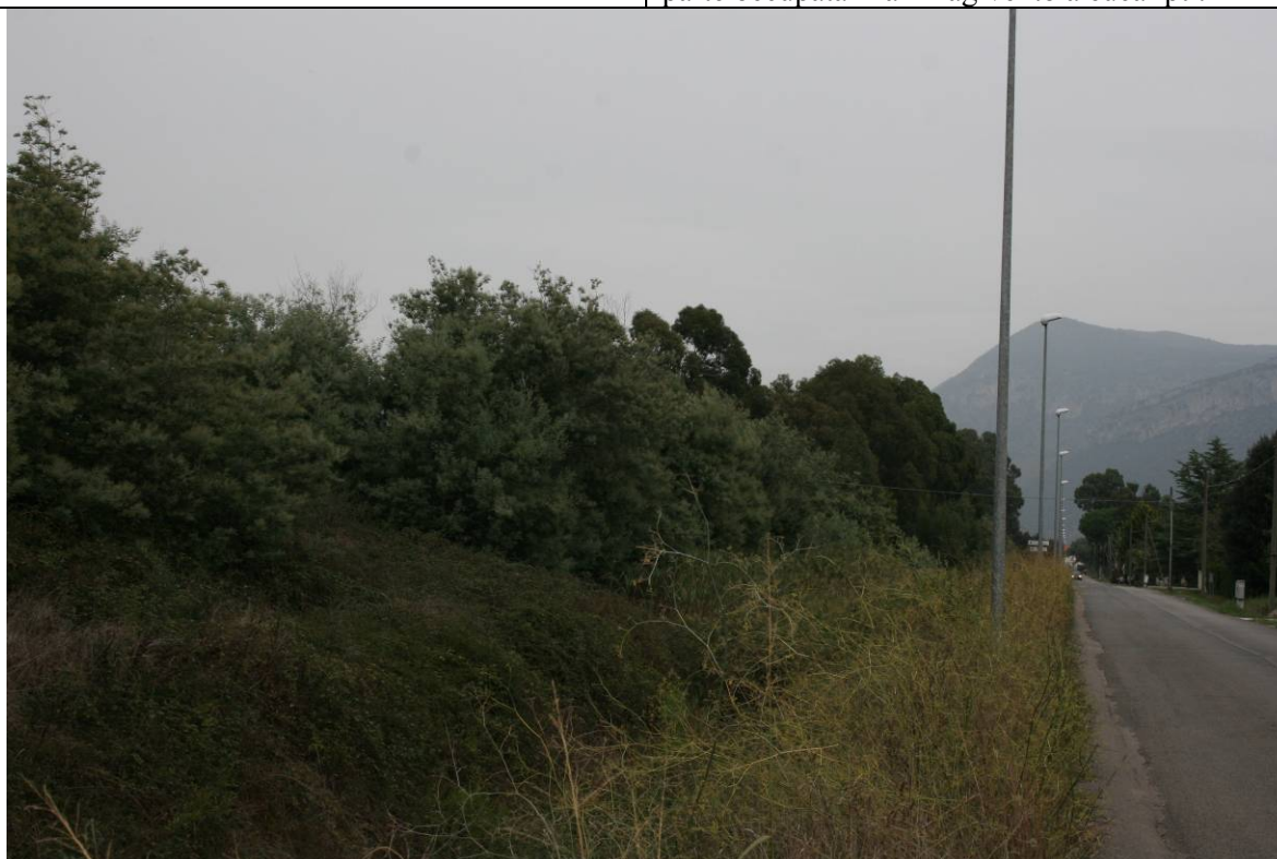
Foto 3 - Canale sollevamento Hermada, che presenta in un tratto limitrofo al borgo, una fascia di vegetazione ripariale totalmente alterata dall'ingresso della pericolosa esotica Acacia saligna
