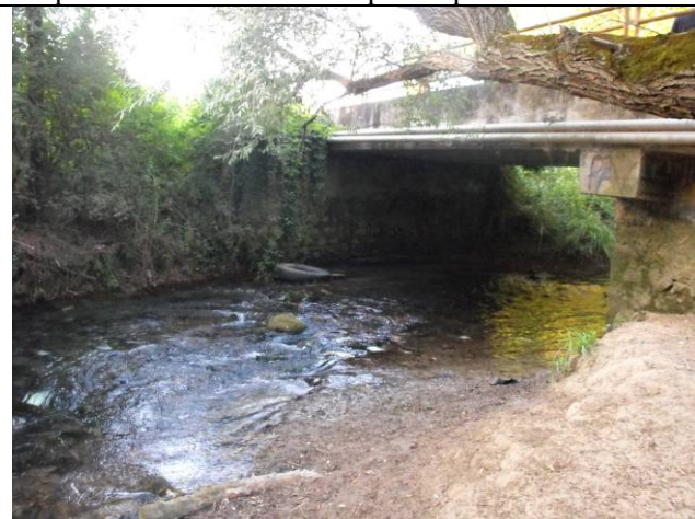
Foto 5 – Rio S. Croce in un tratto degradato.
