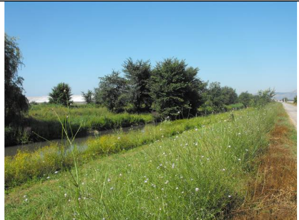
Foto 6 - Ultimo tratto del canale, in cui l'argine
