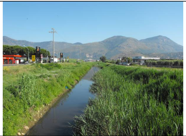
Foto 2 - Il canale Marangio nel primo tratto tra il canale Acqua Chiara e il MOF
