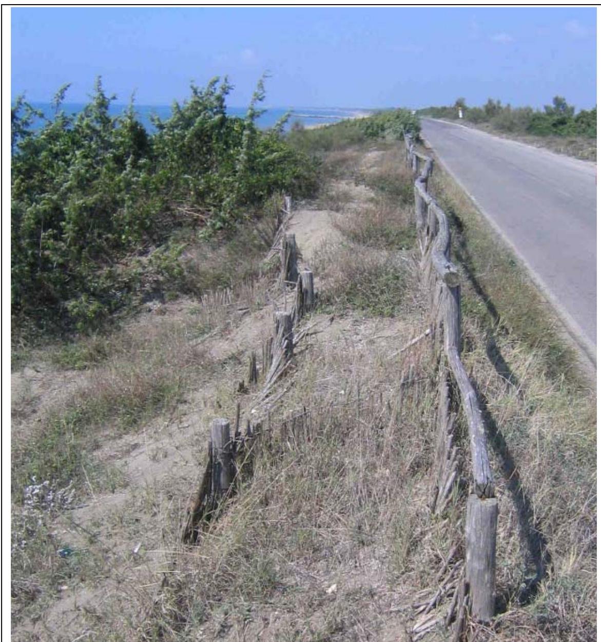
Fig. 6.6 – Installazione di recinzione per la protezione della duna dal calpestio incontrollato e per la riduzione del trasporto eolico verso le aree restrostanti
