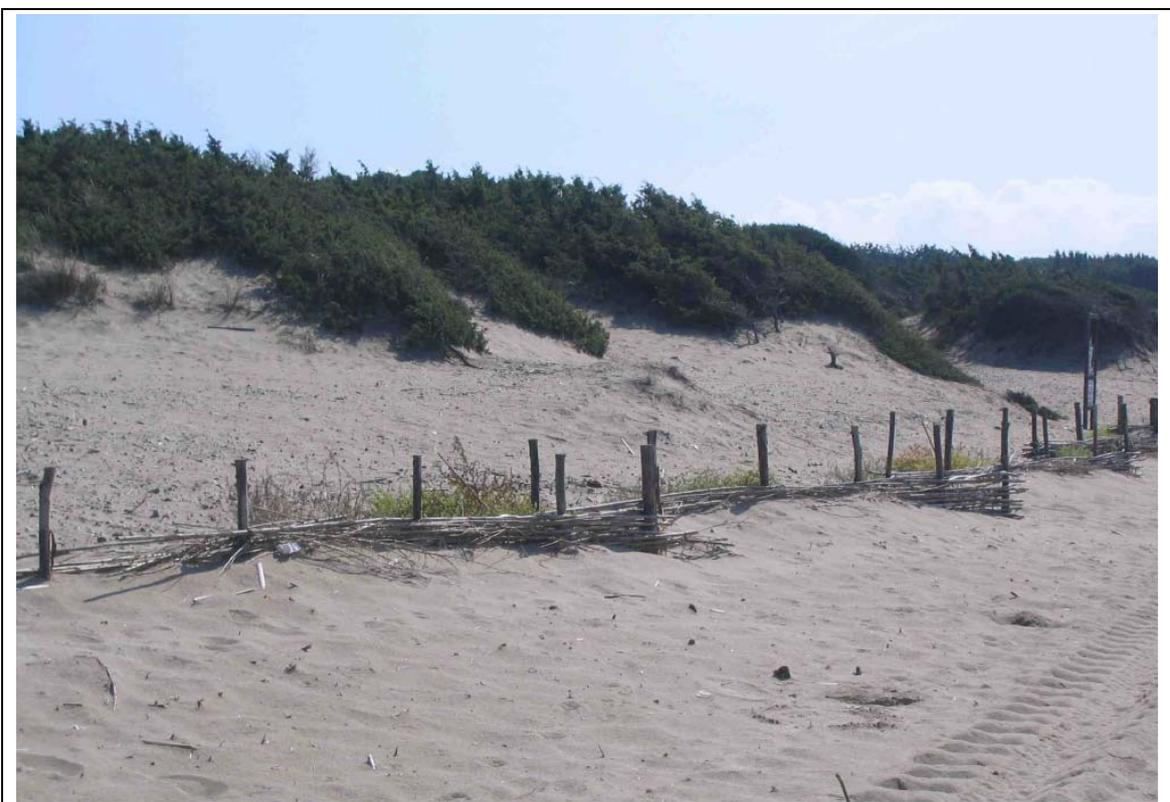
Fig. 6.2 – Installazione di rete frangivento sulla prima fascia di antiduna
