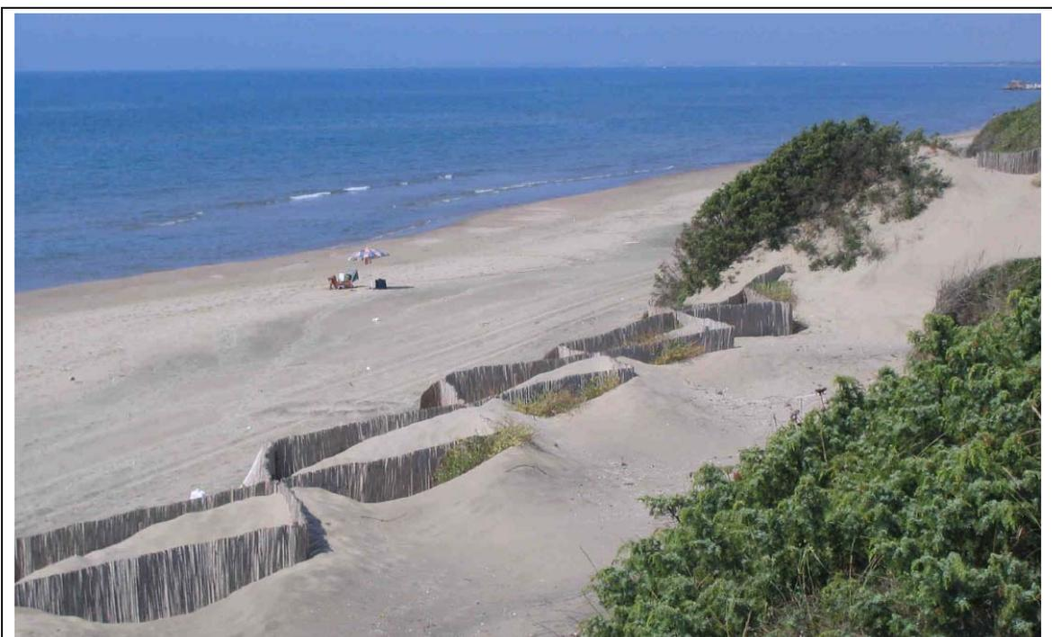
Fig. 6.3 – Installazione di schermo frangivento a scacchiera
