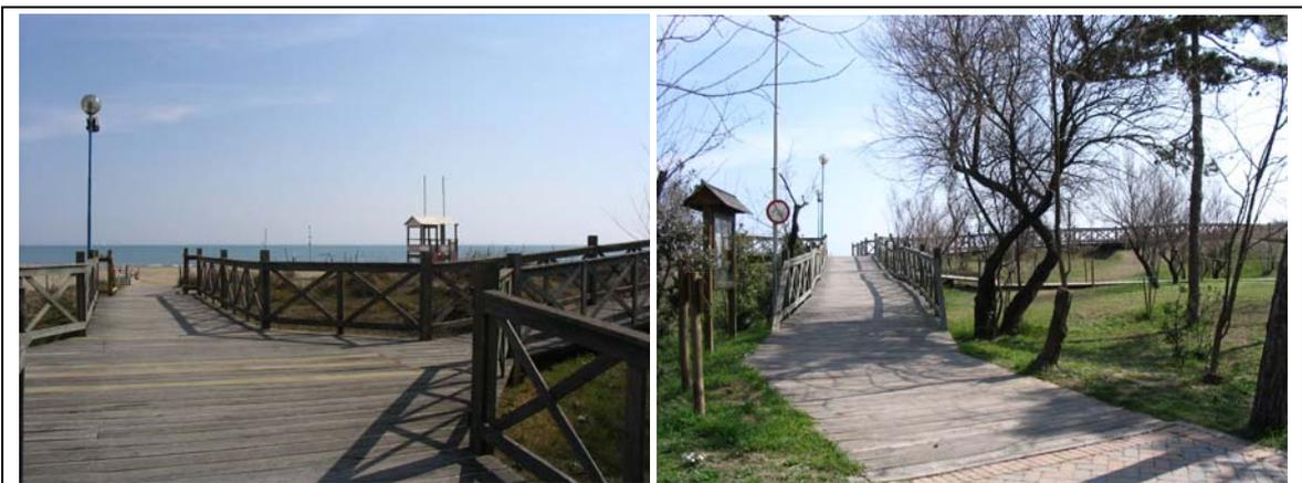
Fig. 6.5 – Realizzazione di passerelle sopraelevate per il superamento della duna
