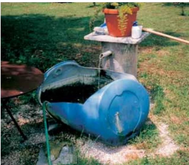
Fig. 2.10 – Due diversi tipi di boccapozzo chiusi all'estremità, rispettivamente con foro e tubo di eduazione. In questo genere di casi l'acqua viene fatta sgorgare permanentemente.
