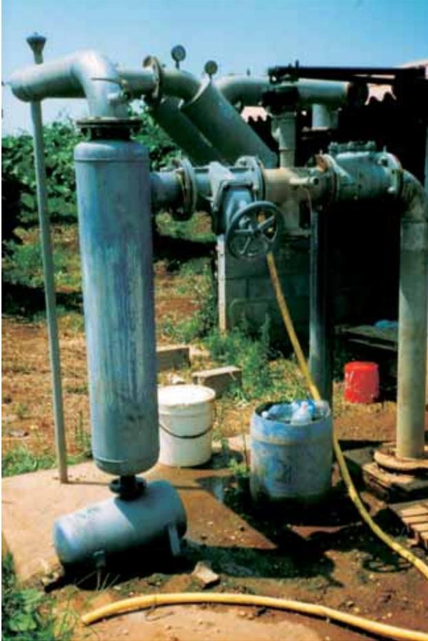
Fig. 2.28 – Filtro anticalcare utilizzato in un'impianto di irrigazione ad aspersione. Si possono notare il boccapozzo sigillato e la valvola di mandata dell'acqua.
