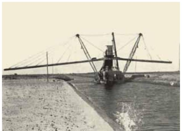
Figura. 1.9 - Draga a secchie per lo scavo dei canali (azionata con motore Diesel). (fonte: Consorzio di Bonifica dell'Agro Pontino)
