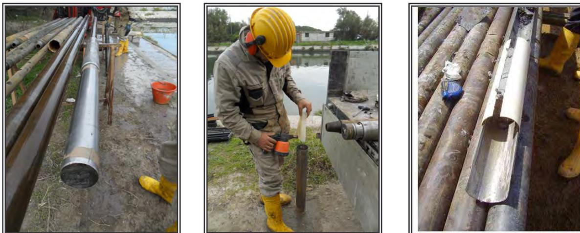
Fig 8: Particolari del prelievo e della preparazione di un campione indisturbato tipo Osterberg.
