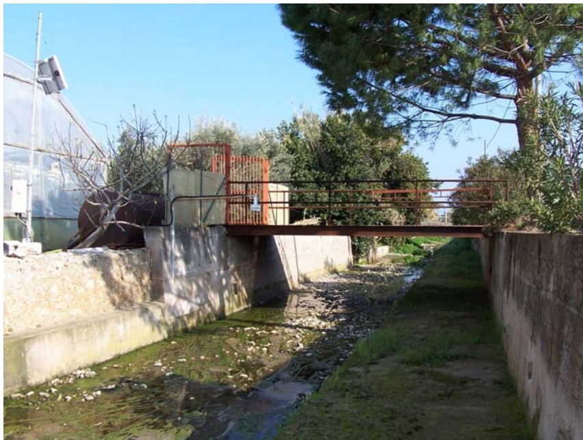
Foto 1 – Alveo del Rio d'Itri e stazione idrometrica con sensore ad ultrasuoni (ST15)
