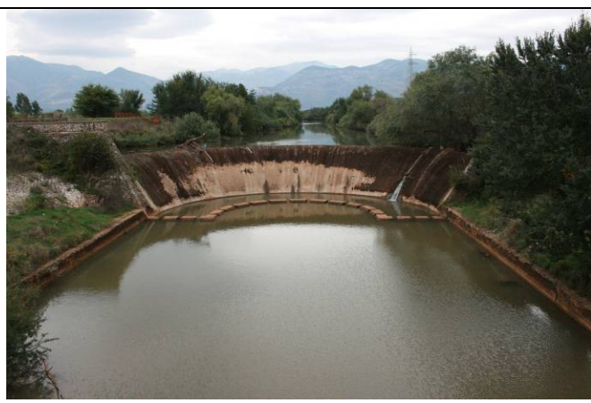
Foto 2 – La diga a sfioro che divide l'alveo originario dell'Amaseno dal Canale diversivo
