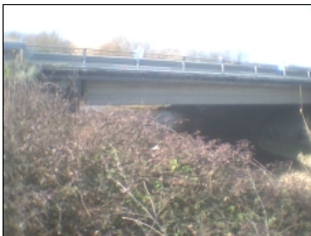
figura 1.2 - Arrone: ponte autostradale – vista da monte
