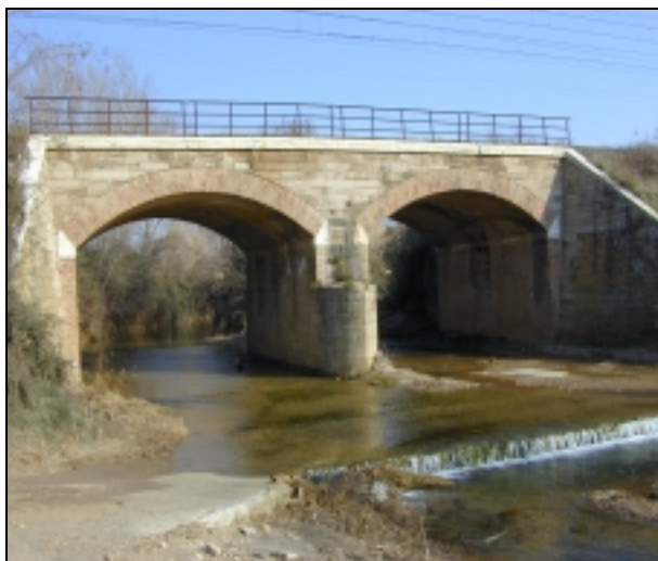
figura 1.25 – Tafone: ponte ferroviario sul Tafone – vista da valle
