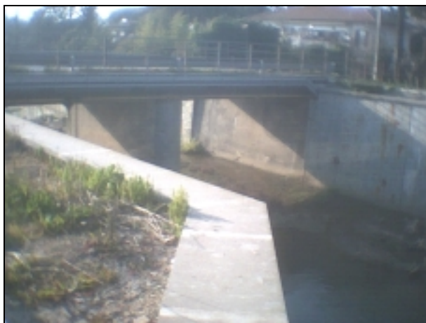
figura 1.5 - Arrone: ponte di Maccarese – vista da monte
