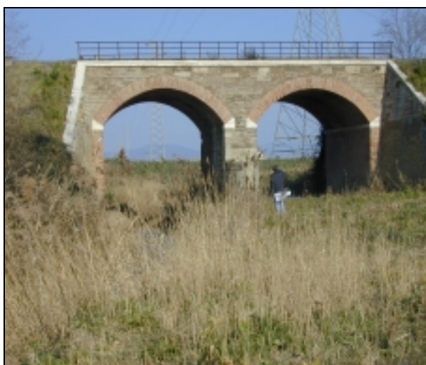
figura 1.26 – Tafone: ponte ferroviario sul Fosso di Ponte Rotto – vista da valle
