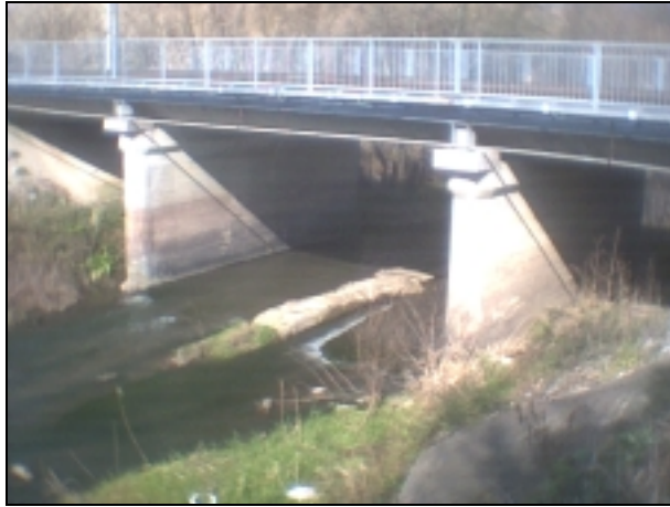
figura 1.3 - Arrone: ponte ferroviario – vista da valle
