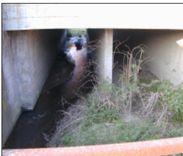
figura 1.8 - Arrone: ponte autostradale – vista da monte
