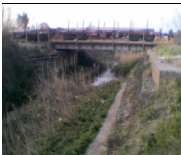
figura 1.10 – Tre Denari: ponte ferroviario – vista da monte
