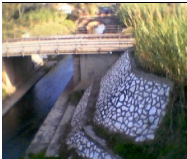
figura 1.18 – Palidoro: ponte ferroviario – vista da valle
