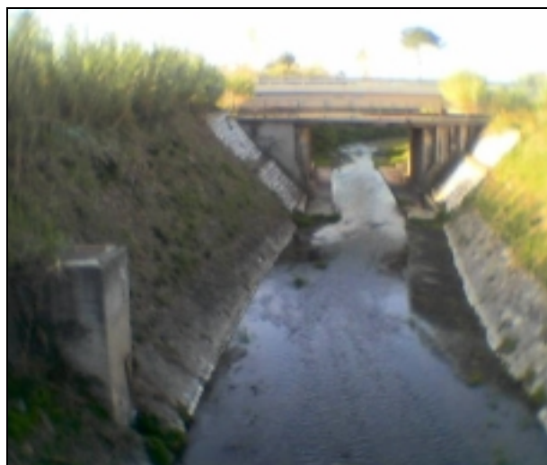
figura 1.17 – Palidoro: ponte ferroviario – vista da monte
