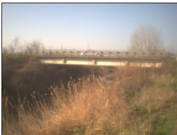
figura 1.1 - Arrone: ponte di via della Muratella – vista da monte
