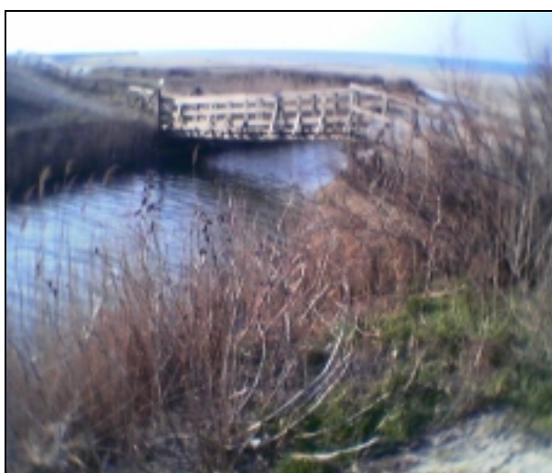
figura 1.14 – Tre Denari: passerella pedonale – vista da monte
