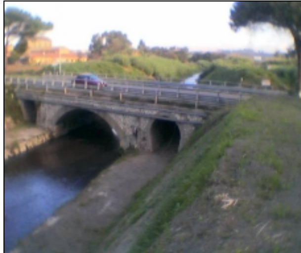
figura 1.15 – Palidoro: ponte di via Aurelia – vista da valle
