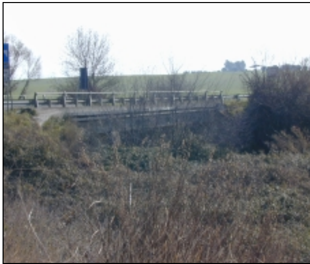
figura 1.23 – Tafone: ponte di via Aurelia – vista da valle
