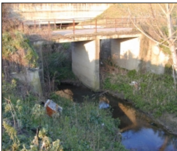
figura 1.7 - Arrone: ponte di via della Torre del Pagliaccetto - vista da monte
