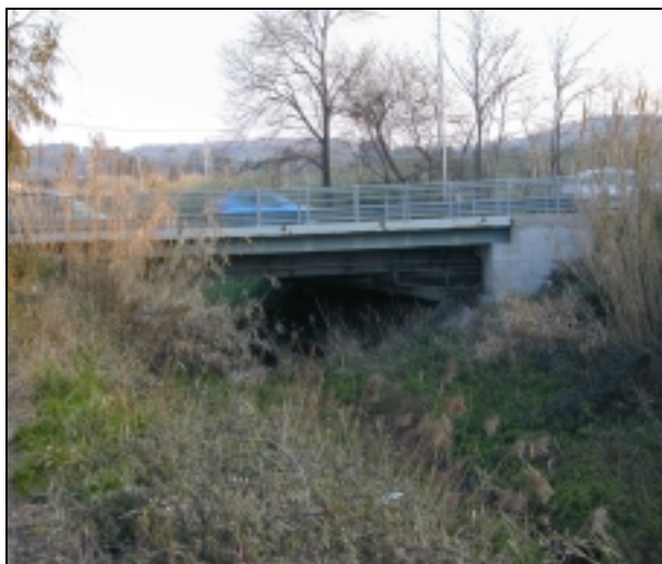
figura 1.9 – Tre Denari: ponte di via Aurelia – vista da valle
