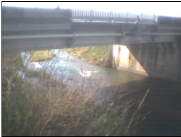
figura 1.4 - Arrone: ponte di via Tre Denari – vista da monte
